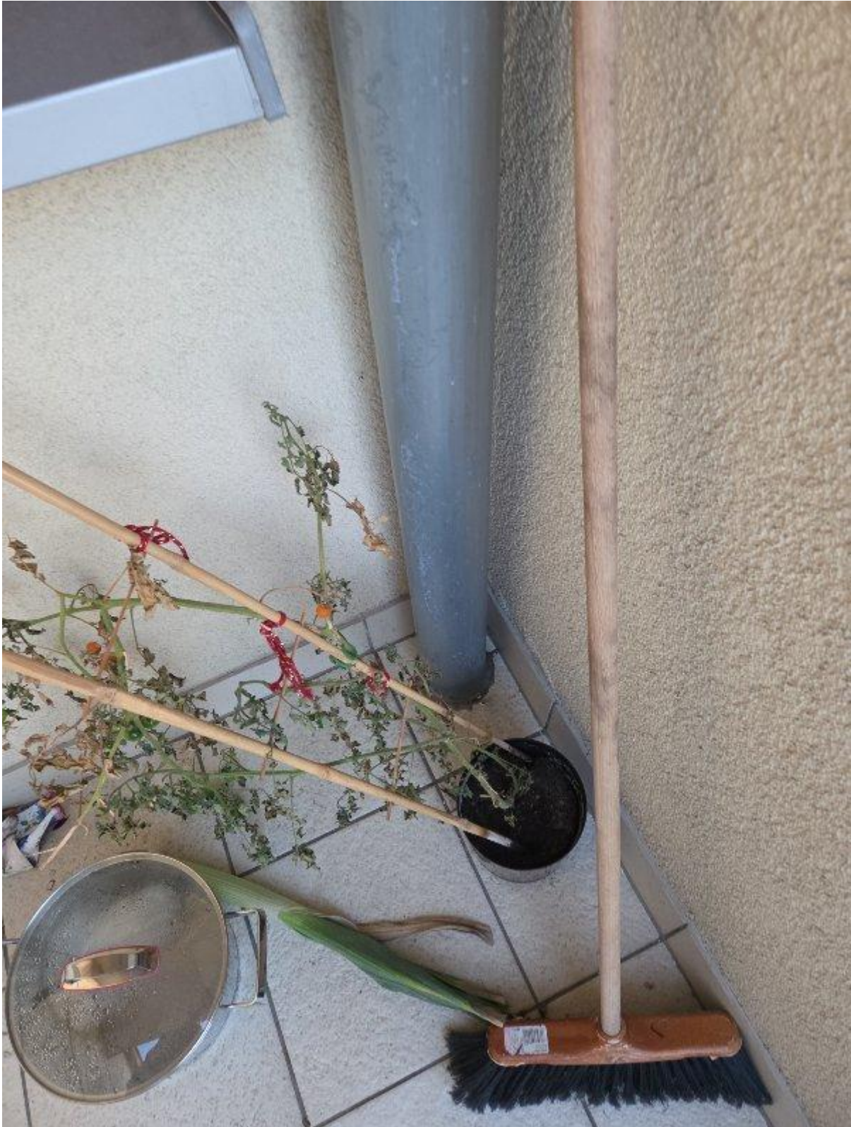
Fot. 24 - Widoczny przepust przez płytę balkonową
